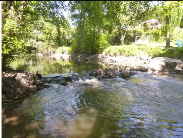
Seuil en enrochements à l'amont de la zone de remous avec hauteur de chute de 20 à 30 cm
