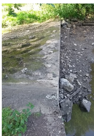
Exemple de désordre de l'ouvrage : éclatement béton
