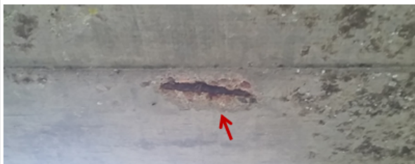
Exemple de désordre de l'ouvrage : éclatement béton
