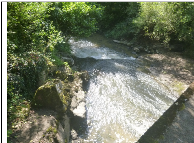
Vitesse d'écoulement assez élevées à l'aval des vannes
